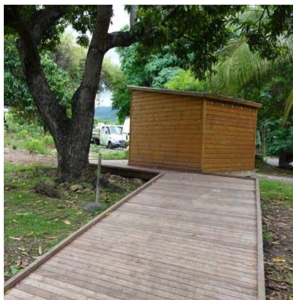
Rehabilitation du platelage bois exotique
