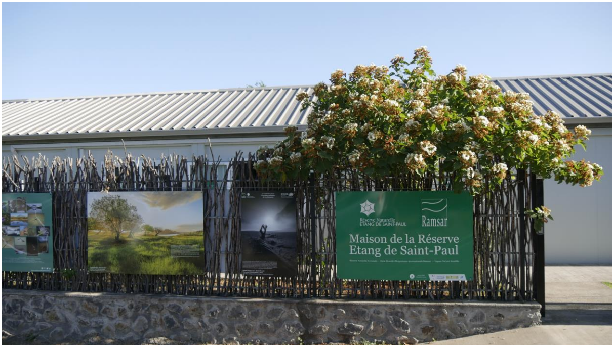
Figure 52 : Maison de la RNNESP – Régie RNNESP
