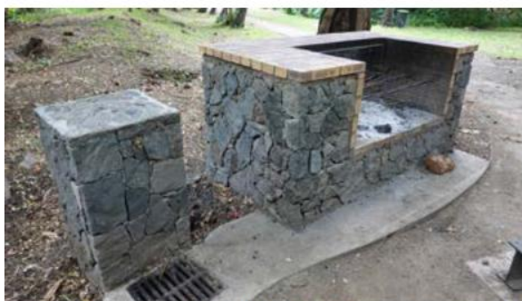
Realisation d'un barbecue et d'une borne fontaine
