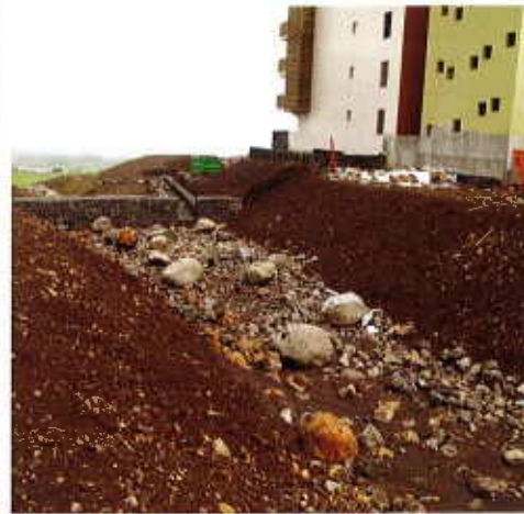
Notre et bief en travaux
