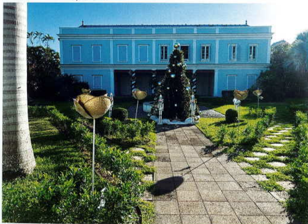
Villa Déramond-Barre à Saint-Denis
