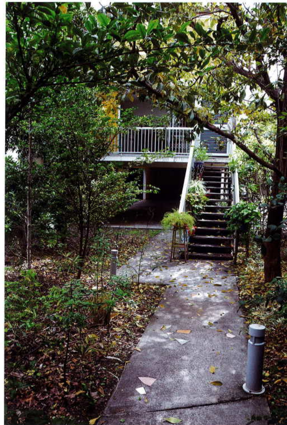
Jardin ombragé de l'Îlet du Centre, immeuble bioclimatique à Saint-Pierre
